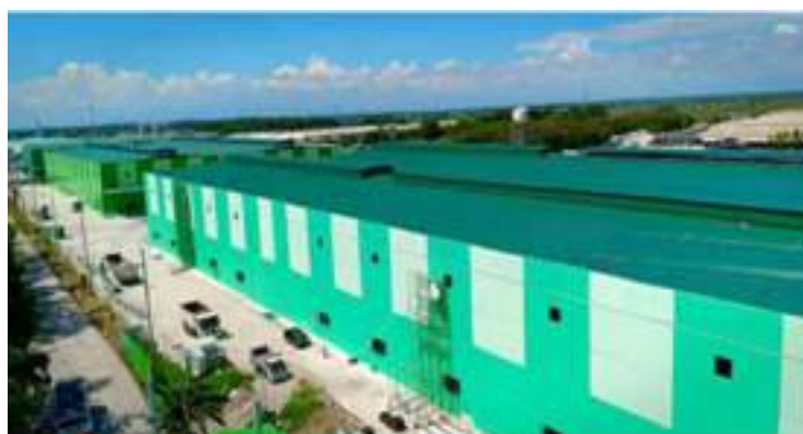
Actual photo of CentralHub-Tarlac
